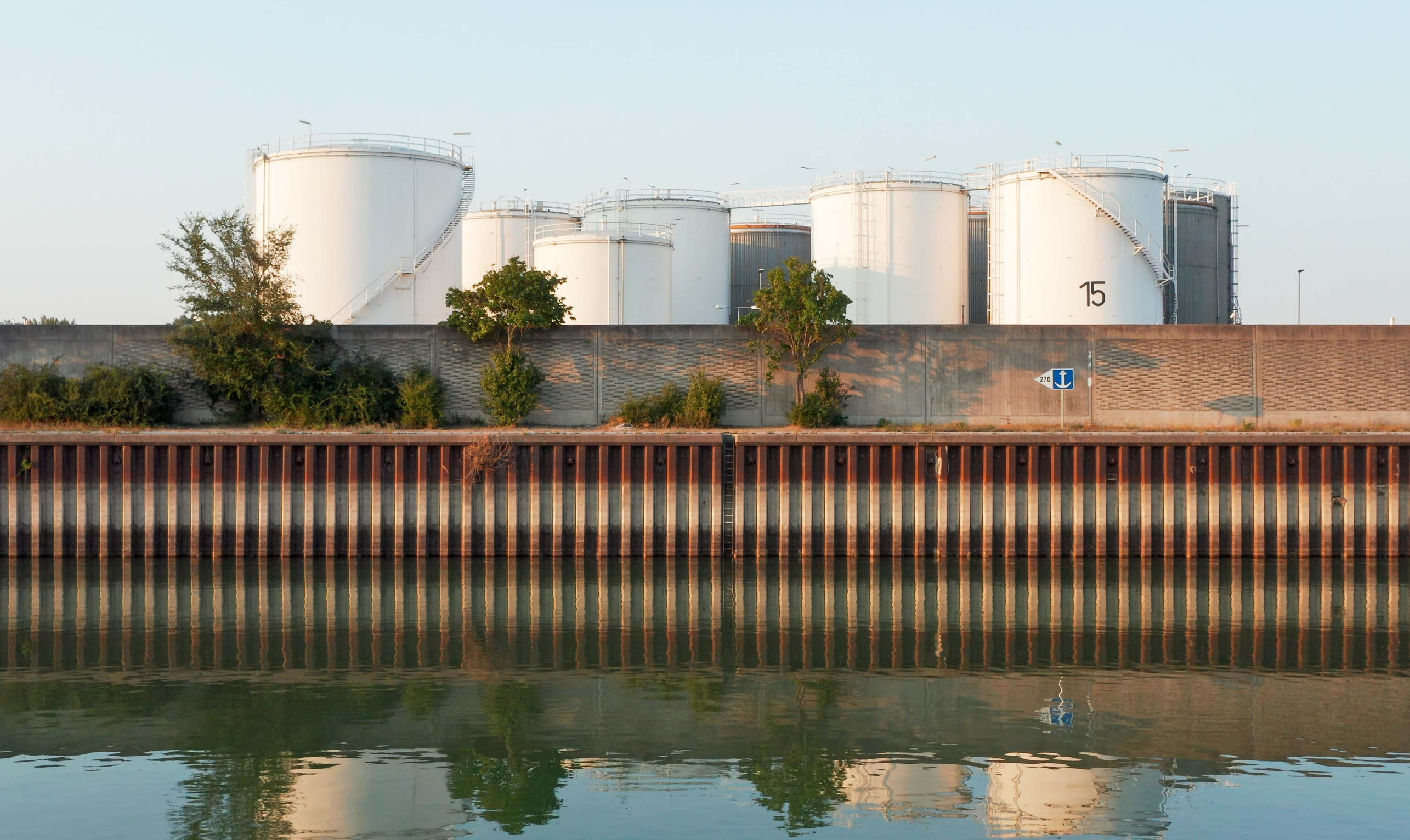
Spundwand und Neue Donau am Ölhafen Lobau, 2022. Sheet pile wall and New Danube at Lobau oil terminal, 2022.
