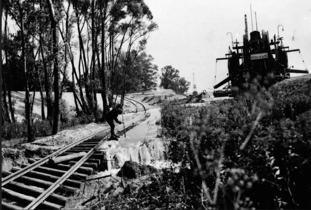
Lobau, Zwangsarbeiter befestigen die Uferböschung mit Schüttsteinen; Blick vom unteren Hafenende Richtung Donau (Sommer 1942)
